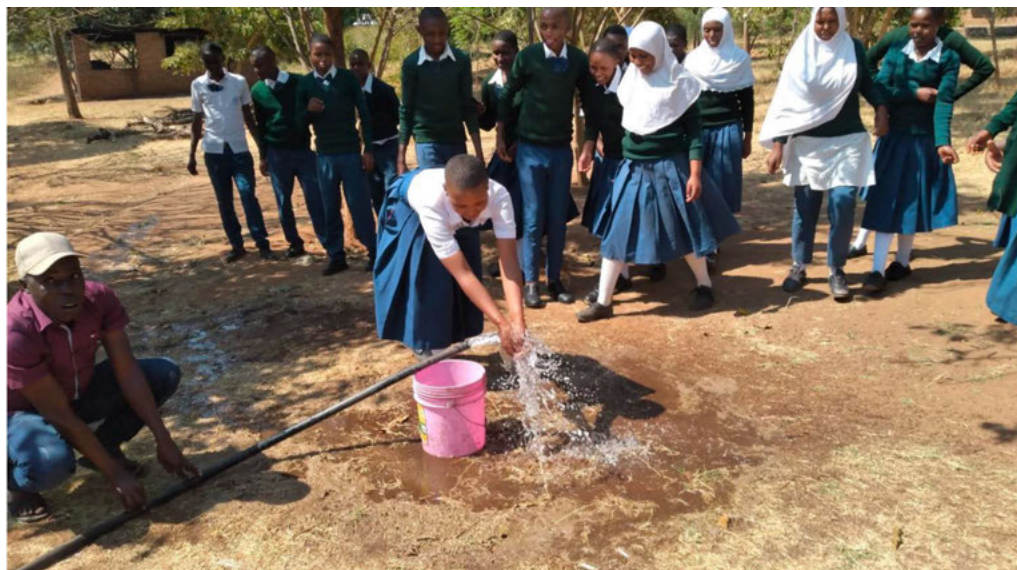
Hier fließt erstmals sauberes Wasser aus einem Tiefbrunnen.
